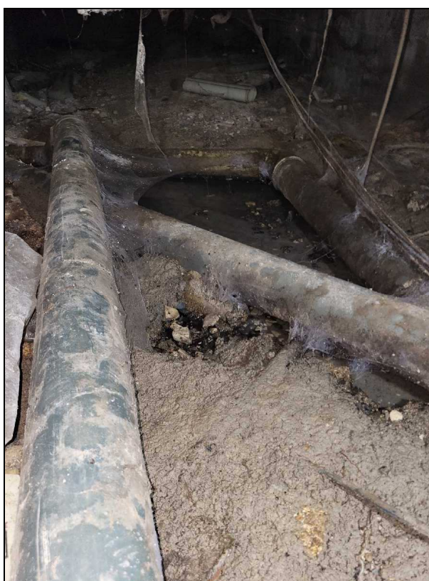
Photos n°12 & n°13 : Vues des nombreux réseaux cheminant dans le vide sanitaire Réseaux fuyards
