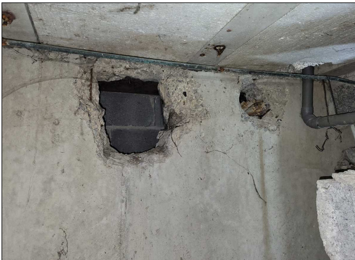
Photo n°30 : Multiples ouvertures dans le voile en béton armé au droit de l'extension à l'extrémité de l'aile Nord
