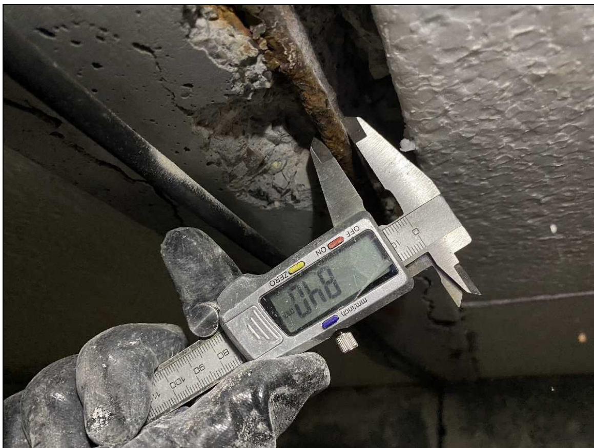
Photos n°46 & n°47 : Fissuration étendue en sous-face du talon des poutrelles suite aux poussées de corrosion Foisonnement de l'armature
