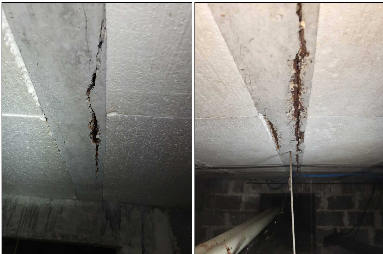
Photos n°7 & n°8 (zoom) : Vues rapprochées des épaufrures et éclats de béton avec armatures apparentes corrodées
