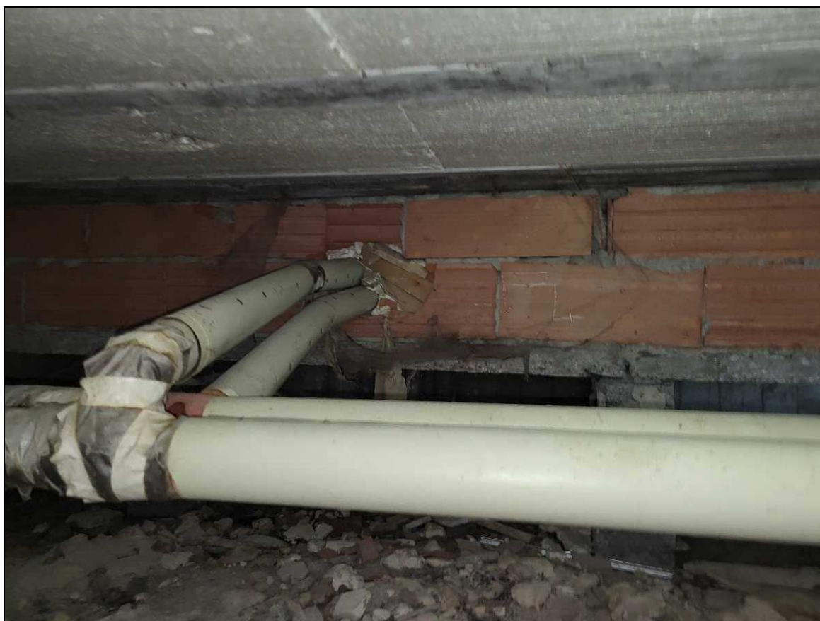
Photo n°9 : Percement de la maçonnerie de briques en rive
