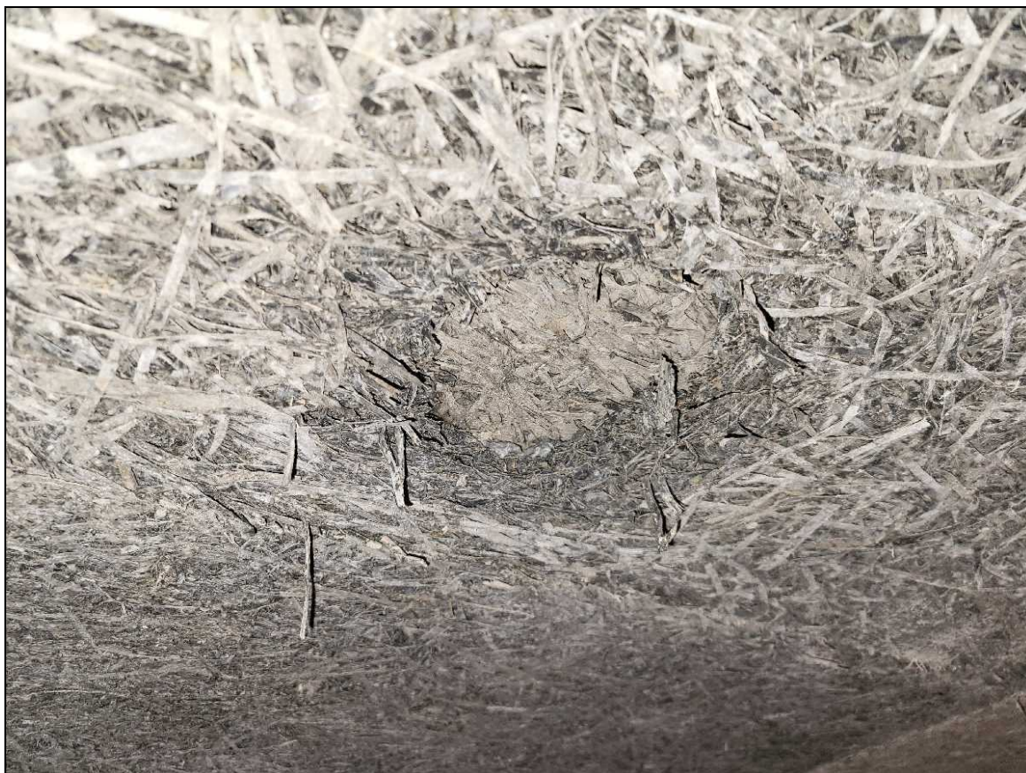
Photo n°21 : Vue rapprochée de l'épaisseur de la protection rapportée de type fibrastyrene®
