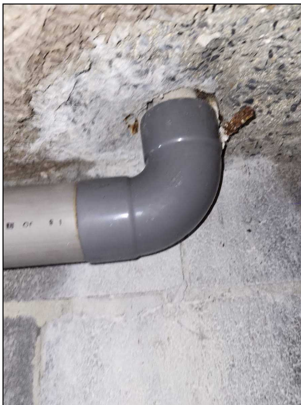
Photo n°25 : Eclat de béton avec armatures apparentes corrodées suite au passage du réseau PVC
