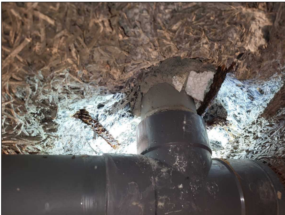
Photo n°23 : Eclat de béton avec armatures apparentes corrodées suite au passage du réseau PVC
