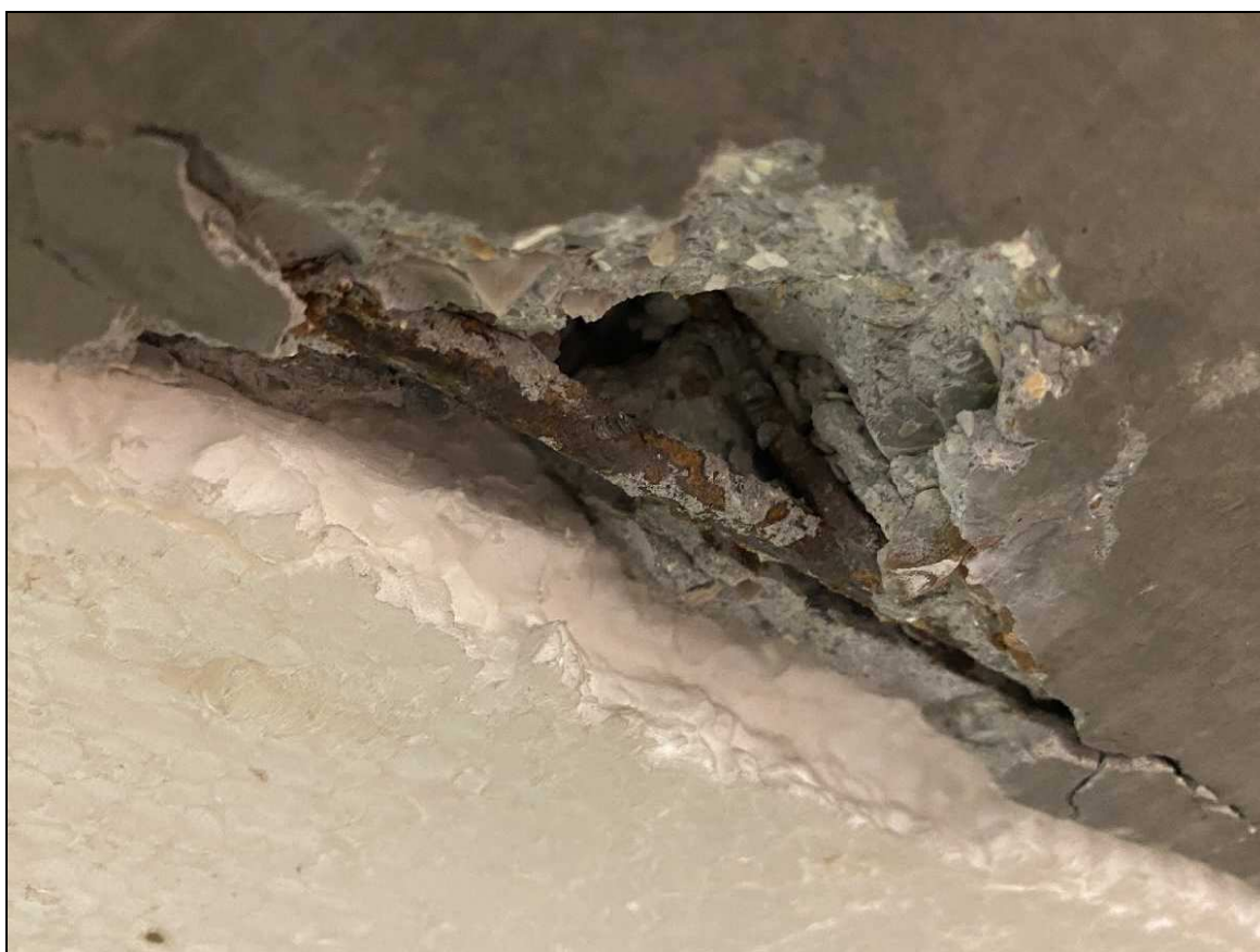
Photos n°56 & n°57 : Zone faiblement dégradée (amorce de fissure) : Armature oxydée
