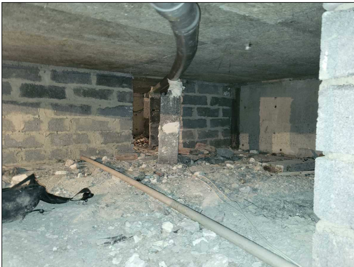
Photo n°26 : Calage des réseaux d'évacuation à l'aide de parpaings (blocs B.B.M) empilés
