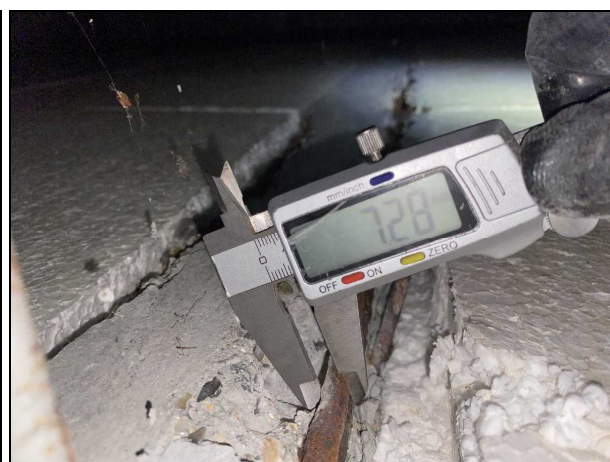
Photos n°38, n°39 & n°40 : Purges des éclats de béton – Armatures entièrement corrodées – Foisonnement des armatures
