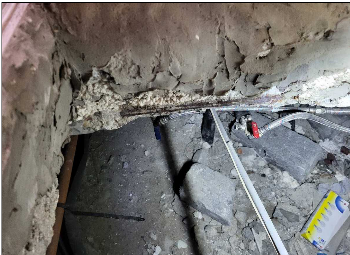
Photo n°29 : Armatures apparentes corrodées visibles au droit de la trémie d'accès au VS
