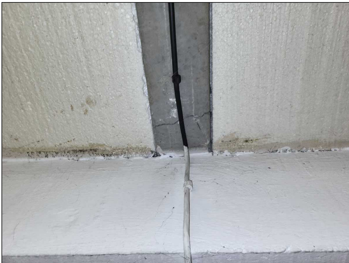
Photos n°3 & n°4 (zoom) : Fissure biaise en about de la poutrelle à proximité de l'appui
