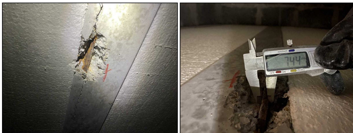
Photos n°49 & n°50 : Purges des éclats de béton – Armatures corrodées – Foisonnement des armatures
