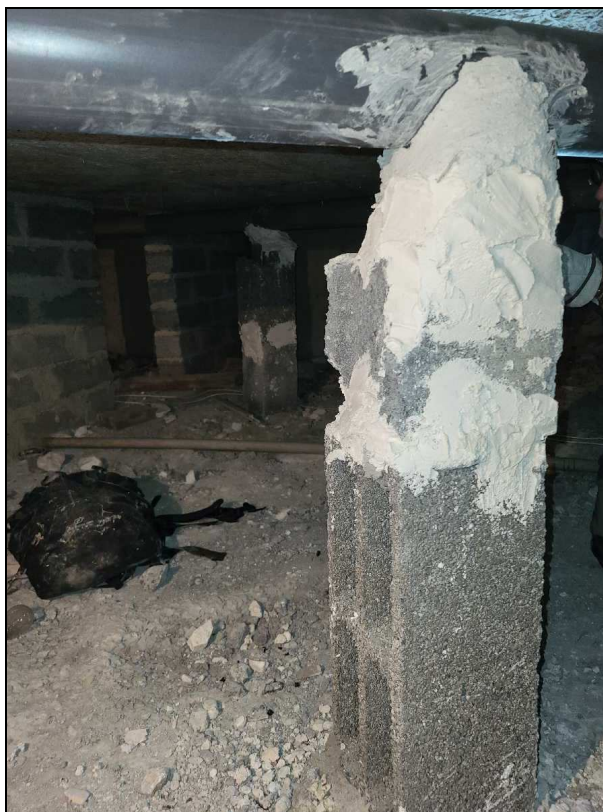
Photo n°28 : Calage des réseaux d'évacuation à l'aide de parpaings (blocs B.B.M) empilés et maçonnés à l'aide de plâtre
