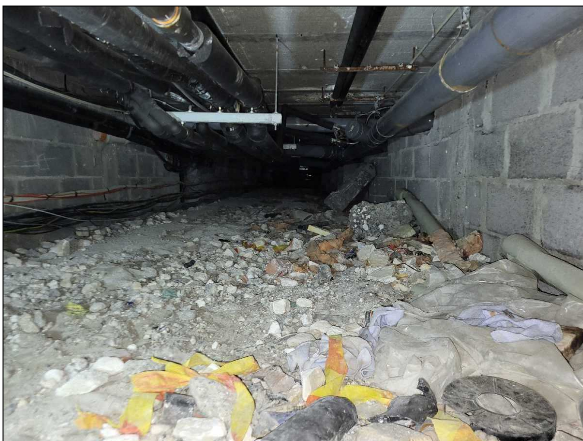
Photo n°31 : Présence de gravats et d'une multitude de débris sur le sol Présence de nombreux réseaux fixés en sous-face du plancher dans la zone de circulation
