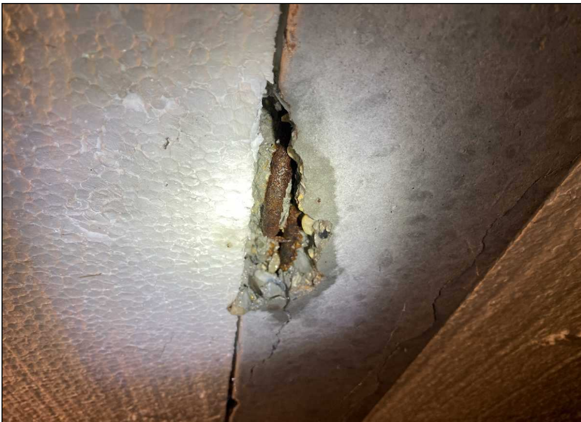
Photo n°52 : Béton carbonaté
