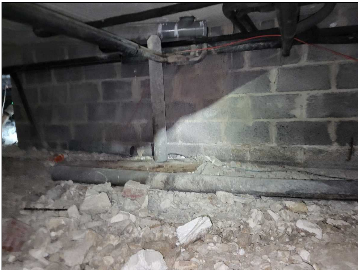
Photo n°36 : Calage des réseaux d'évacuation à l'aide de bastaings bous et morceaux de tuyaux PVC
