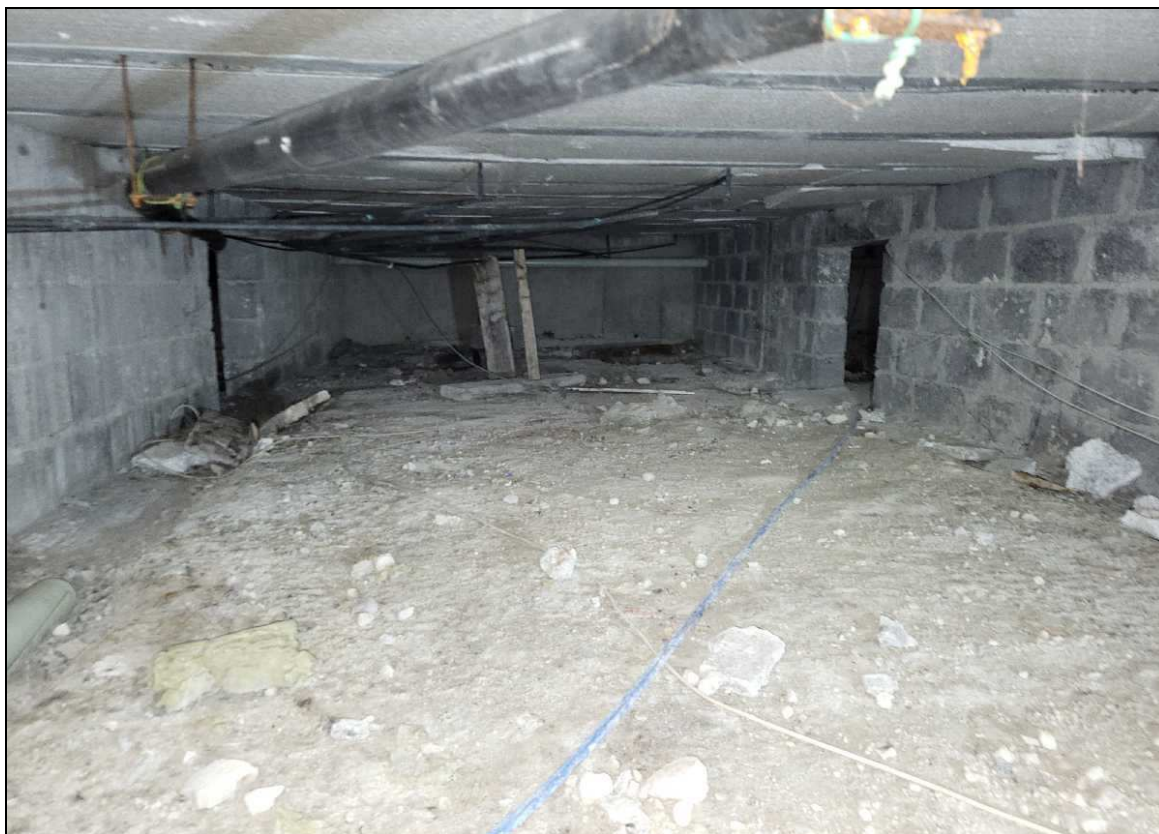
Photo n°19 : Calage des réseaux d'évacuation à l'aide de bastinges en bois
