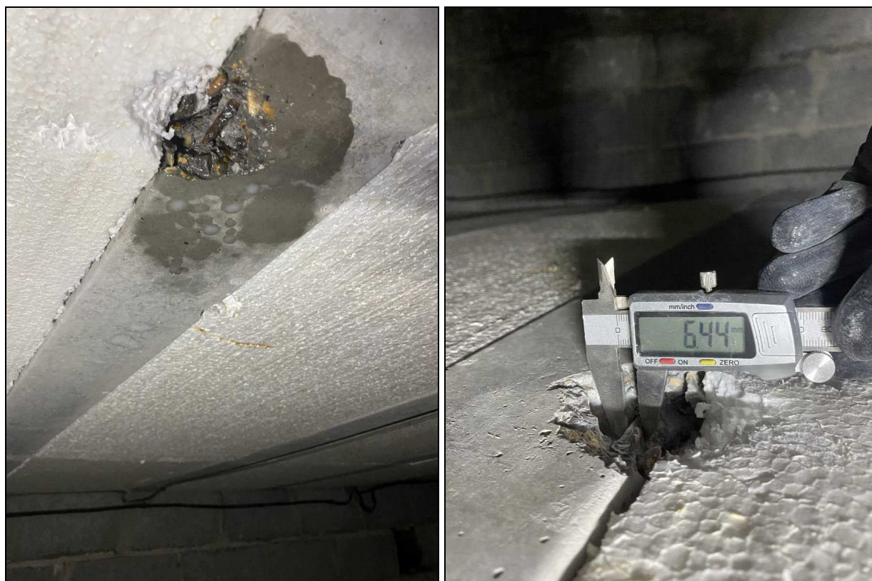
Photos n°54 & n°55 : Zone saine (sans désordre) : Armature saine, sans oxydation
