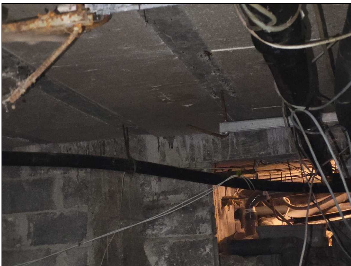
Photos n°16 & n°17 : Fixation anarchiques des réseaux dans les poutrelles préfabriquées Epaufures et éclats de béton avec armatures apparentes corrodées
