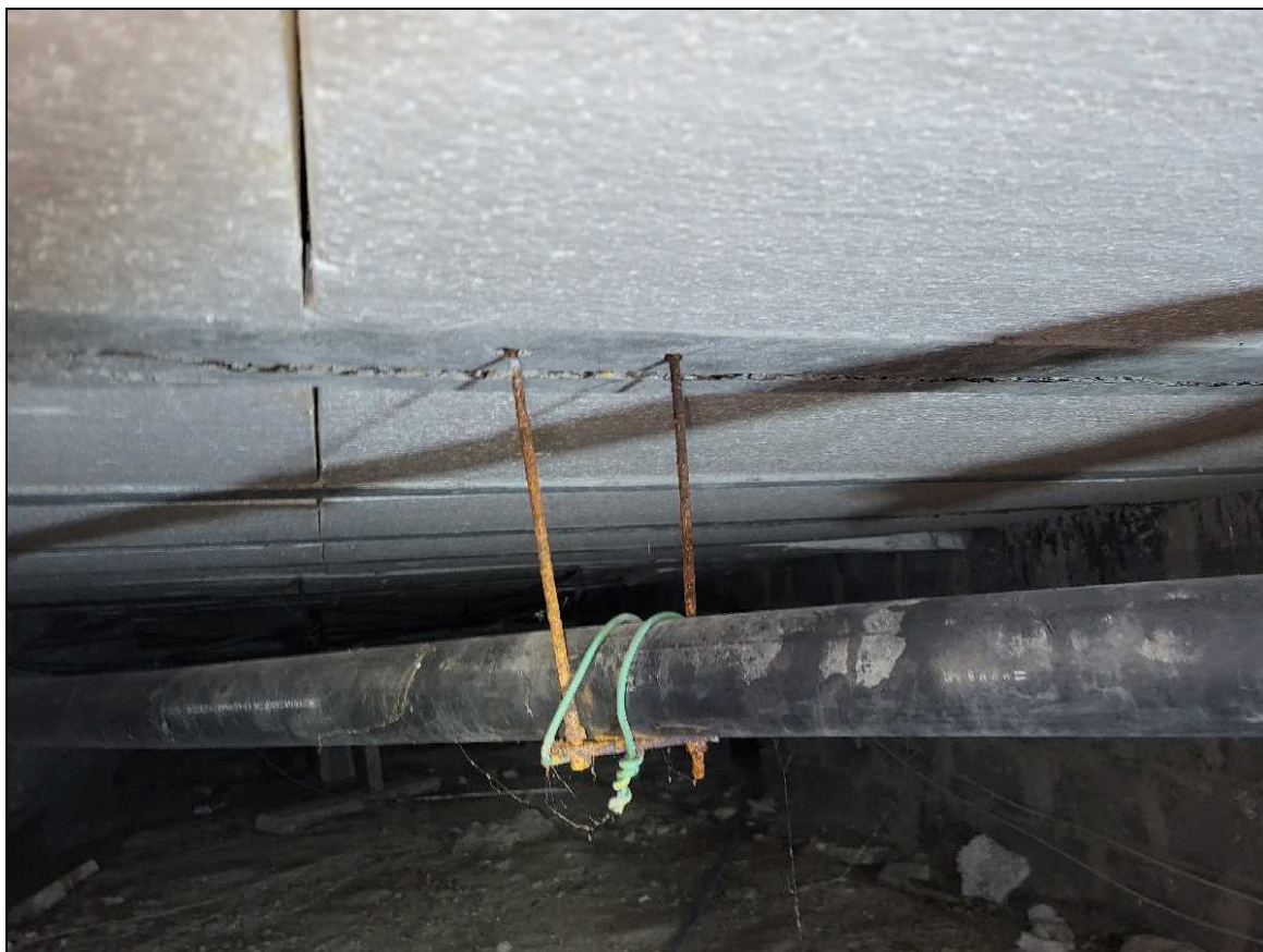
Photo n°18 : Fixation anarchiques des réseaux dans les poutrelles préfabriquées Epaufures et éclats de béton avec armatures apparentes corrodées
