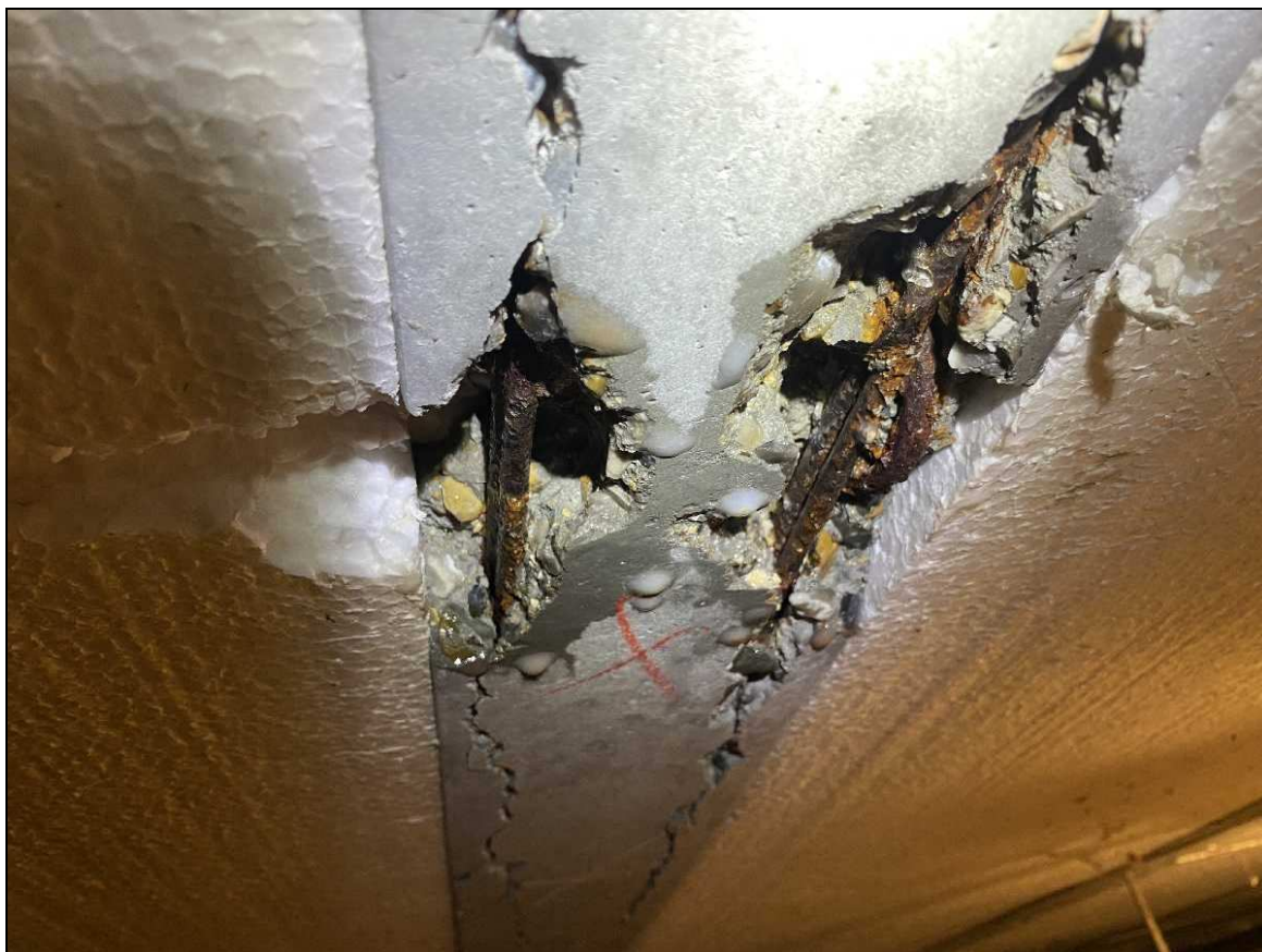
Photo n°53 : Béton entièrement carbonaté
