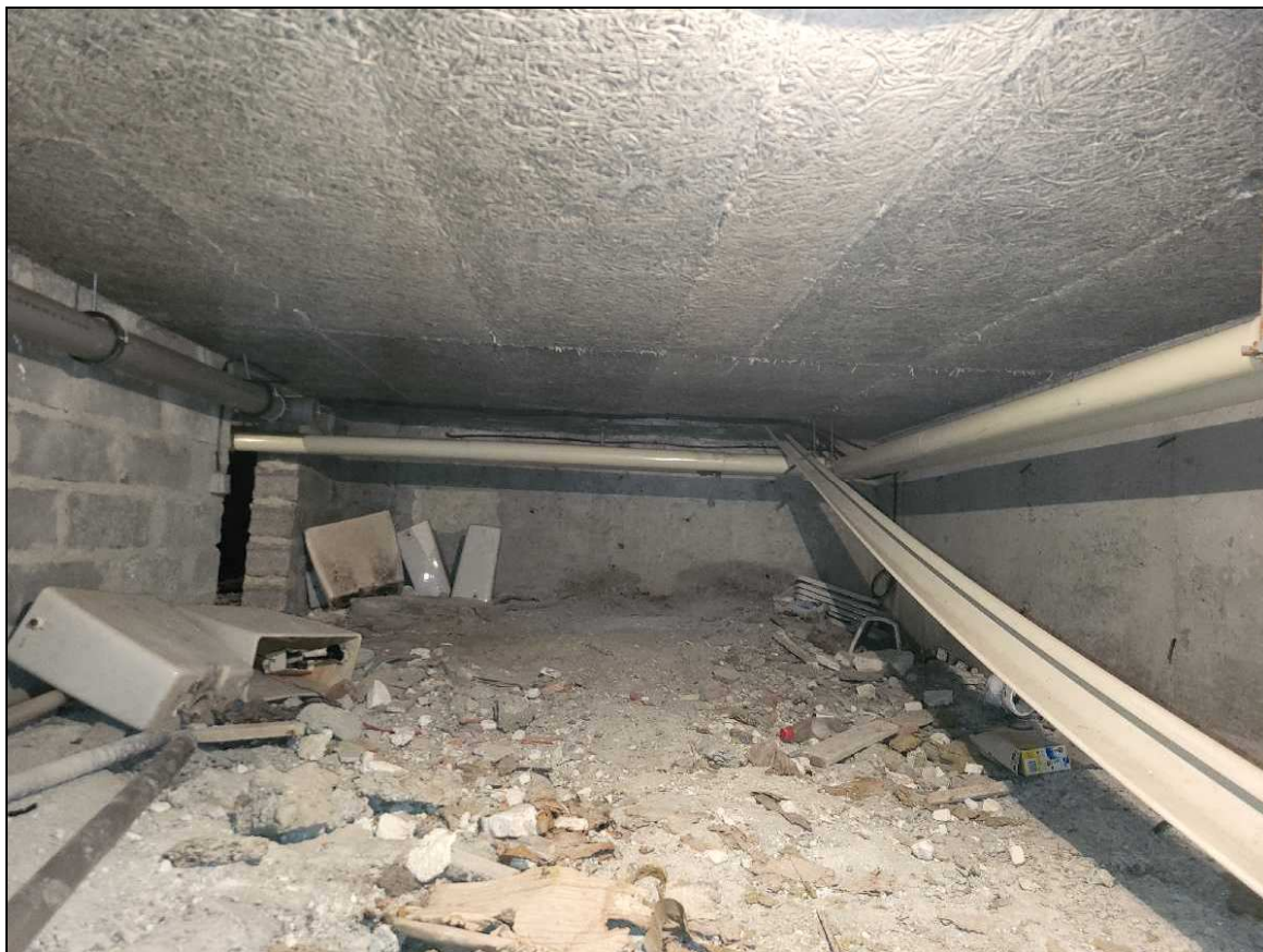
Photo n°20 : Principe constructif différent - Dalle pleine en béton armé avec protection rapportée de type fibrastyrène®
