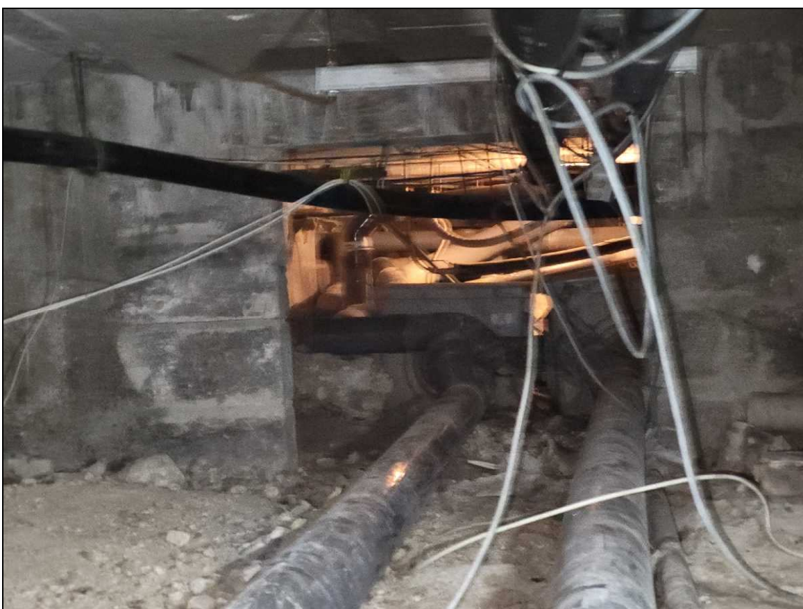
Photos n°10 & n°11 : Vues des nombreux réseaux cheminant dans le vide sanitaire
