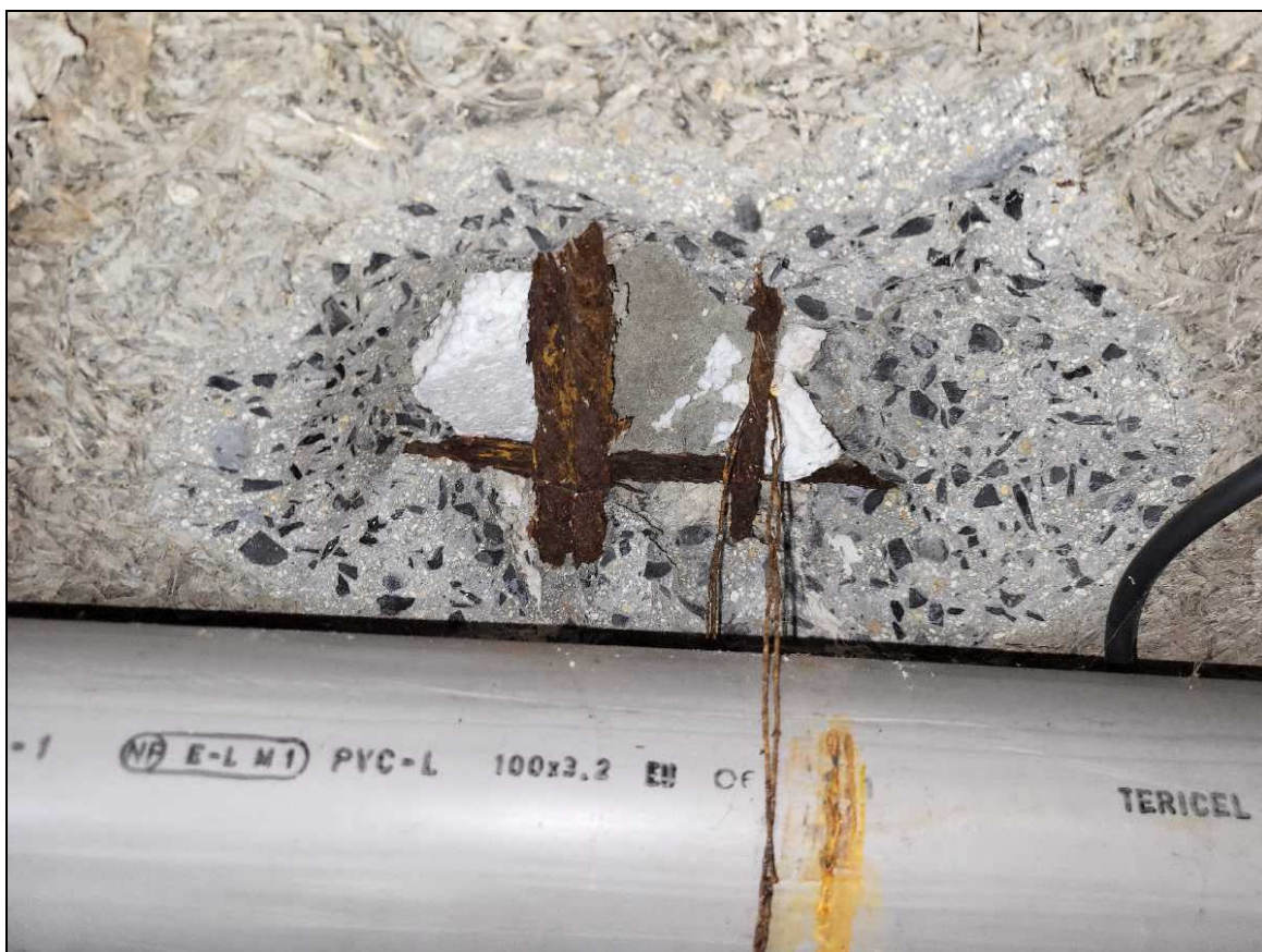
Photo n°24 : Corrosion très avancée des armatures avec éclat de béton suite au percement réalisé
