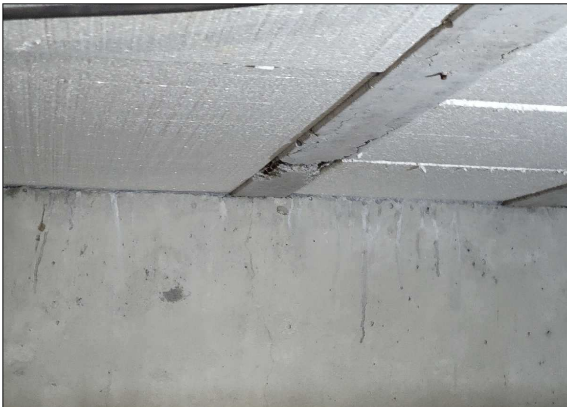
Photos n°5 & n°6 (zoom) : Vues d'ensemble et rapprochée des fissures visibles en sous-face des poutrelles – Fixation des réseaux
