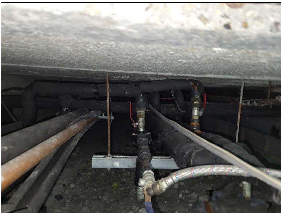
Photos n°32 & n°33 : Présence de nombreux réseaux fixés en sous-face du plancher dans la zone de circulation
