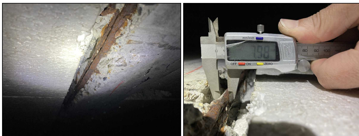
Photos n°41, n°42 & n°43 : Purges des éclats de béton – Armatures entièrement corrodées – Foisonnement des armatures
