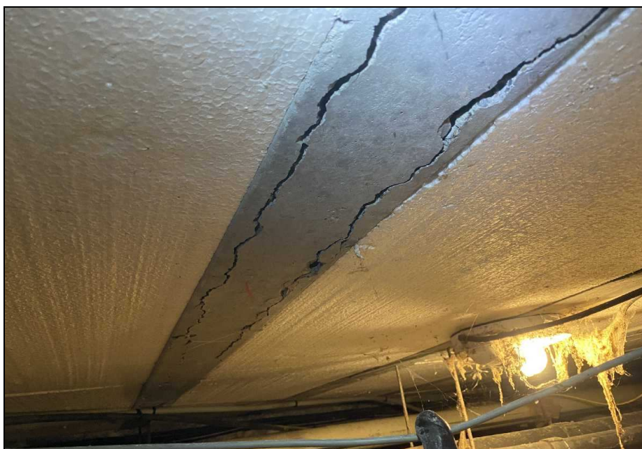
Photo n°37 : Fissuration étendue en sous-face du talon des poutrelles suite aux poussées de corrosion
